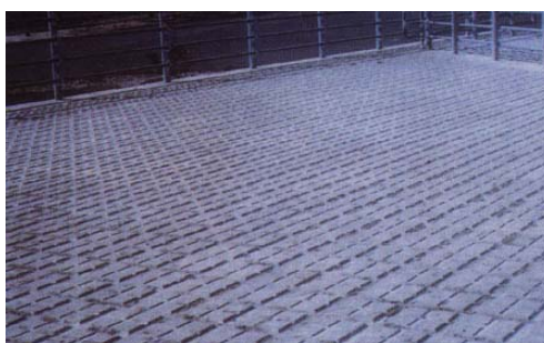
Фиг. 23: Бетонен под на бокс с релефни мотиви за предпазване от подхлъзване
